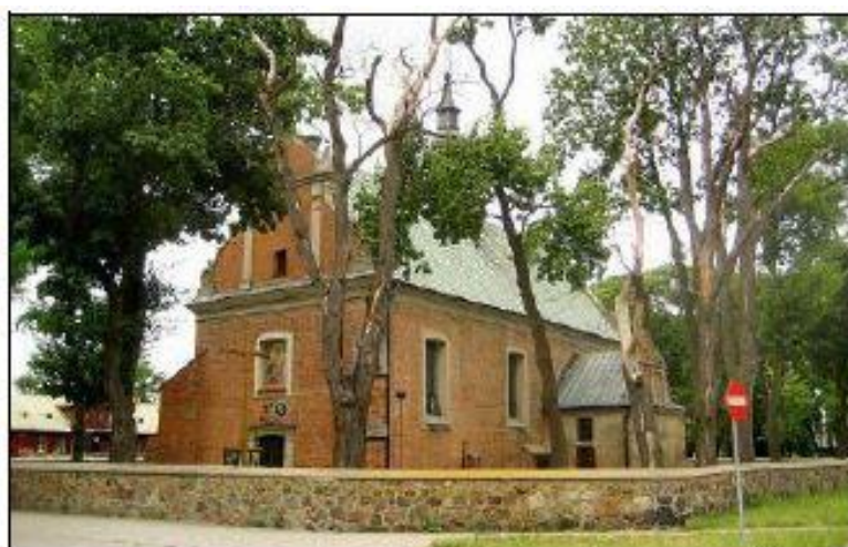
Rysunek 12 Kościół parafialny w Drobinie [Studium uwarunkowań i kierunków zagospodarowania przestrzennego Gminy Drobin]
