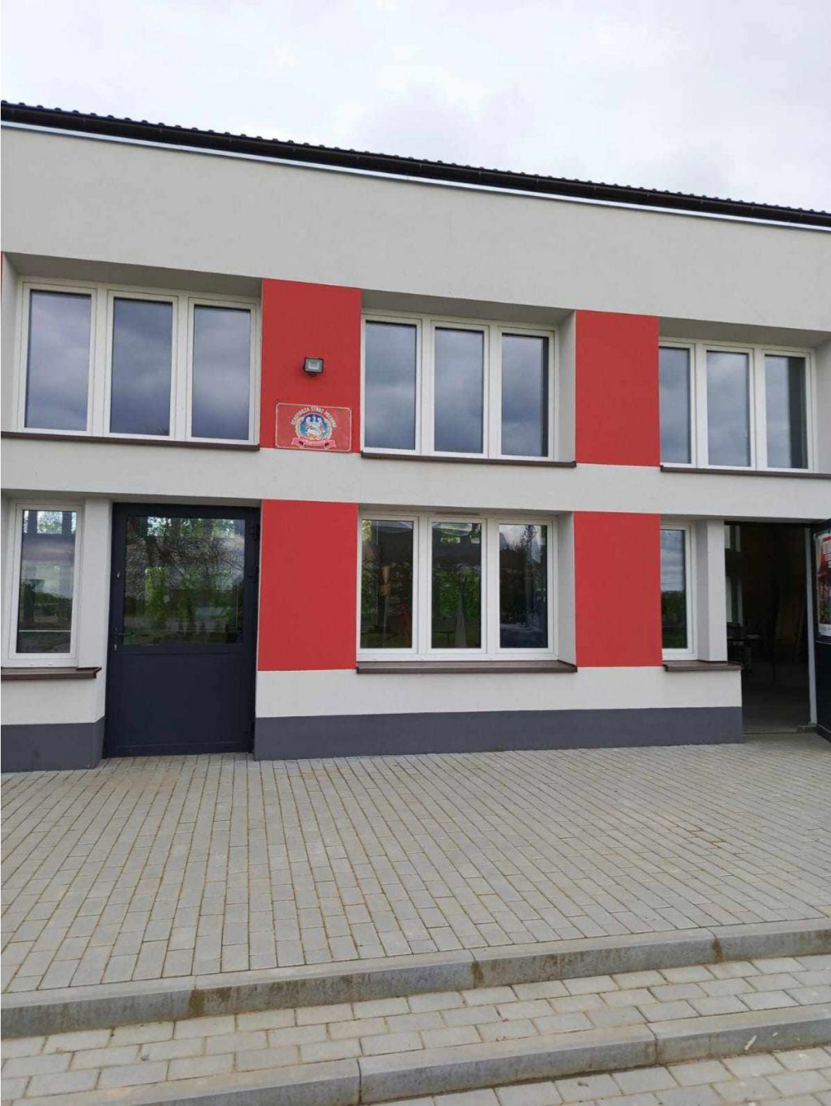
OSP Rogotwórsk po termomodernizacji
