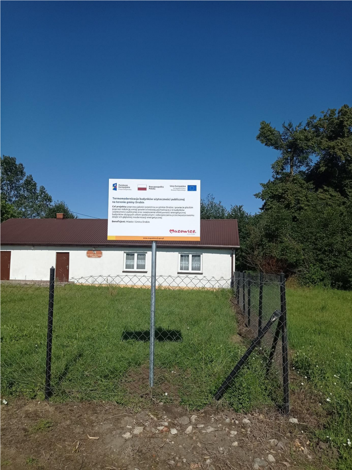
OSP Nagórki Dobrskie przed termomodernizacją
