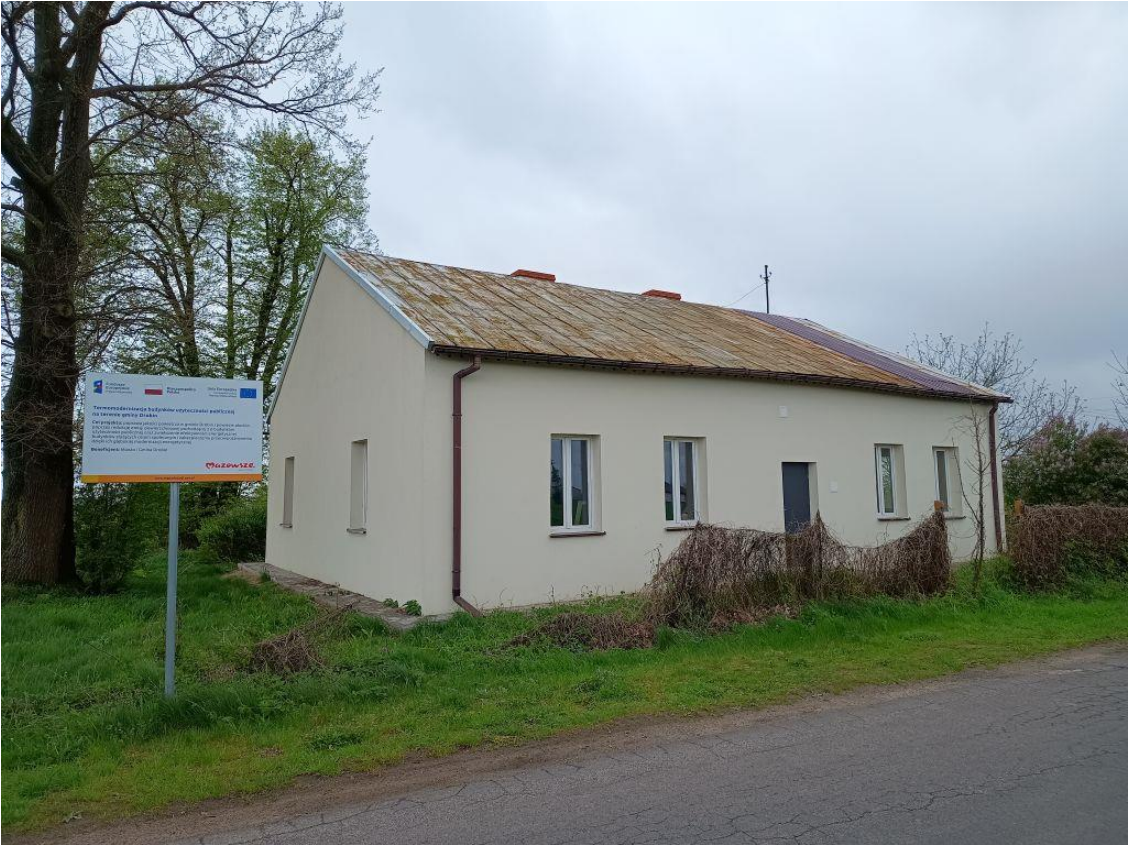
ŚW po termomodernizacji
